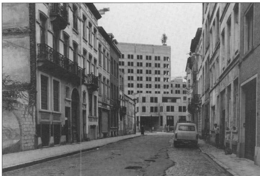
Quartier Harmonie: rénovation de la ville de Bruxelles. A côté des peintures murales, les immeubles 3-9 avant la rénovation
