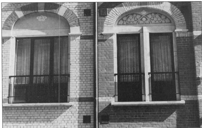
Les façades de la rue du Travail retrouvent leurs couleurs après le sablage et la restauration des mosaïques
