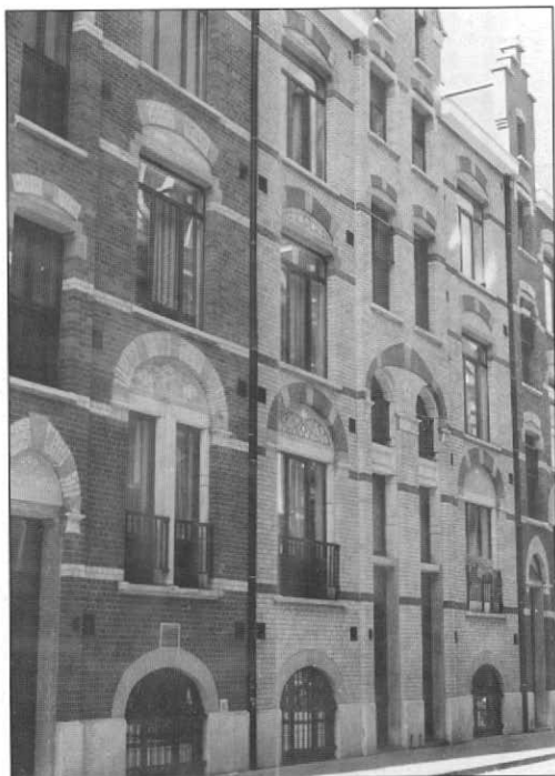
La rue du Travail rénovée après des années d'abandon. Seules les façades ont pu être sauvegardées
