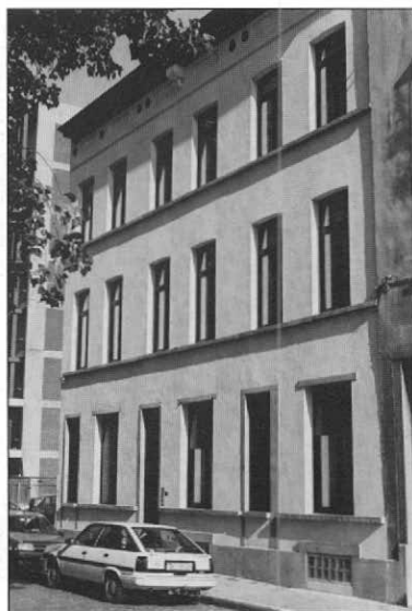
Quartier Harmonie: rénovation de la ville de Bruxelles. Trois immeubles de la rue du Faubourg (19 à 23) transformés en huit petits appartements
