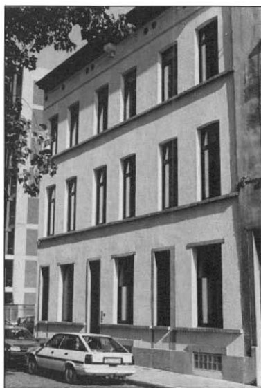
Stadsrenovatie Harmoniebuurt. De drie panden in de Voorstadsstraat 19 tot 23 omgebouwd tot 8 kleine appartementen.
