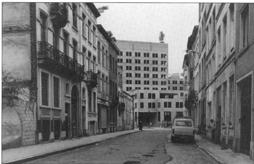
Stadsrenovatie Harmoniebuurt. Naast de muurschilderij de Harmoniestraat 3-9 voor de renovatie.
